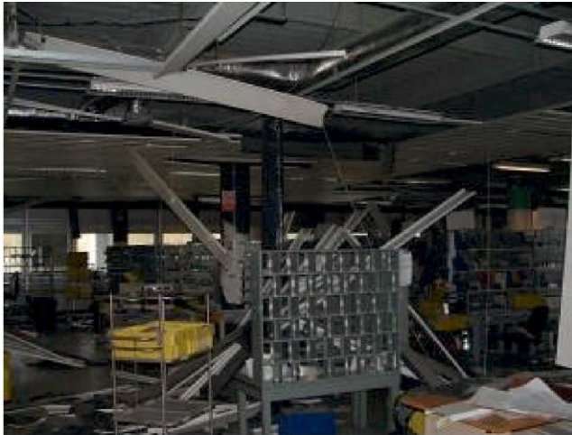
Edificio postale – Sisma Abruzzo
